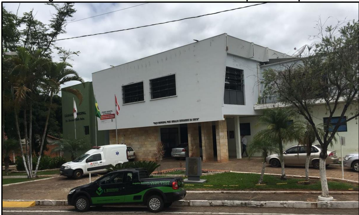
Figura 7 - Vista da fachada da Prefeitura Municipal de Pratópolis.
