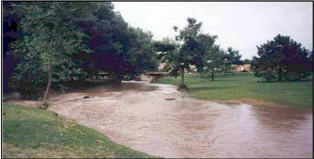
Figura 51 - Reservatório de Detenção Gramado Durante a Cheia
