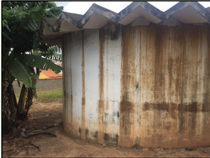
Figura 21 - Vista do Reservatório R02
