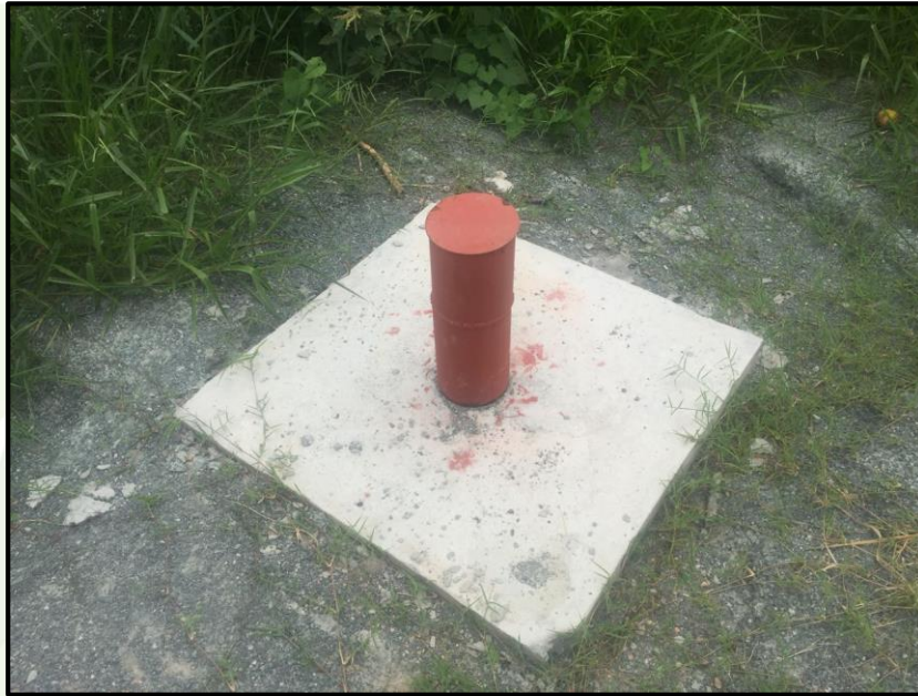
Figura 19 - Poço 03 Desativado no Distrito de Três Fontes
