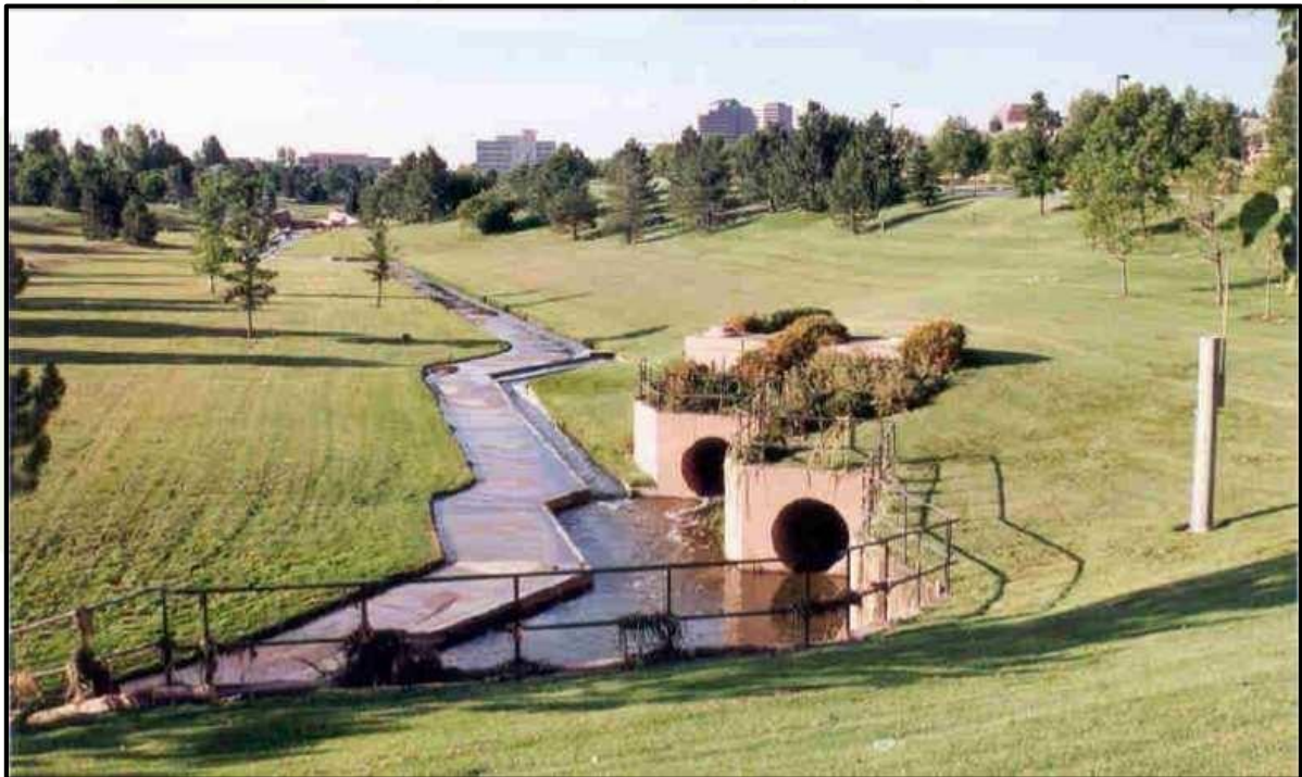
Figura 44 - Reservatório de detenção seca construída no Wallace Park, Denver-USA, utilizado para controle de enchentes, e recreação no período seco
