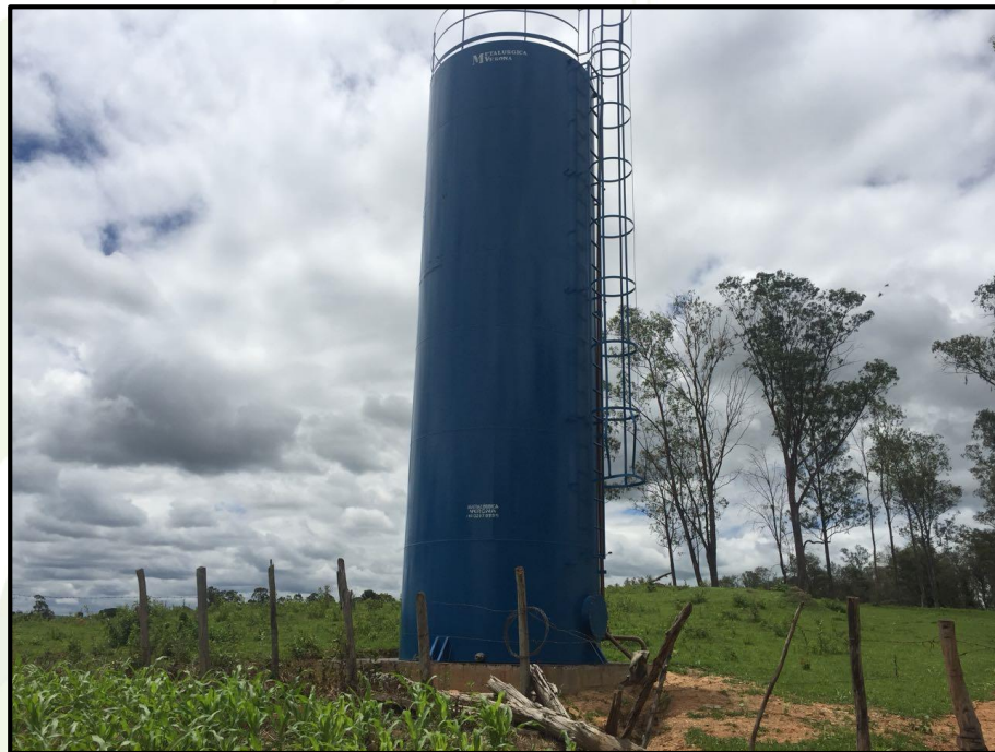
Figura 26 - Vista do Reservatório R05
