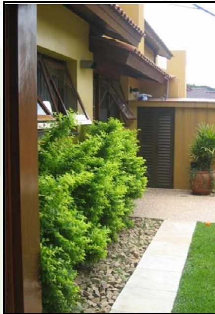
Figura 53 - Trincheira de Infiltração em Lote Residencial
