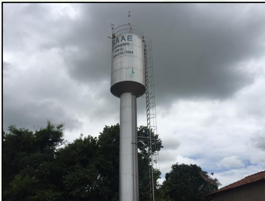
Figura 23 - Vista do Reservatório R03
