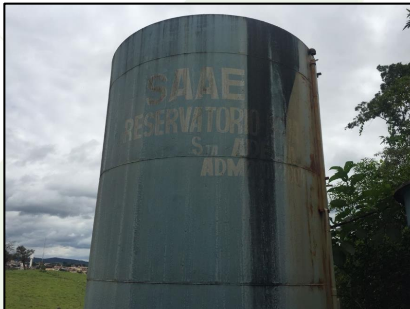
Figura 24 - Vista do Reservatório R04
