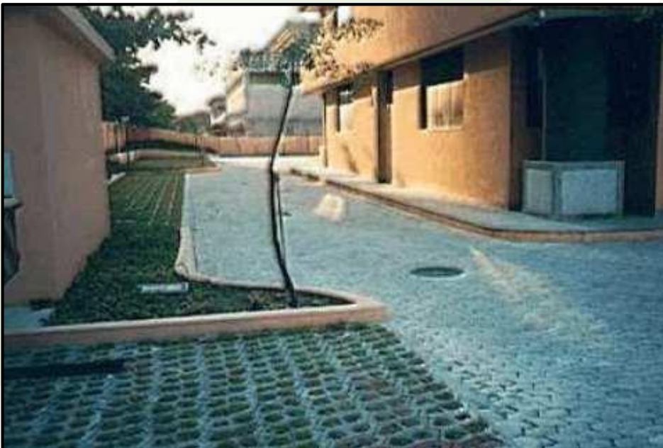
Figura 56 - Pavimentação com Blocos Vazados para Favorecer a Infiltração
