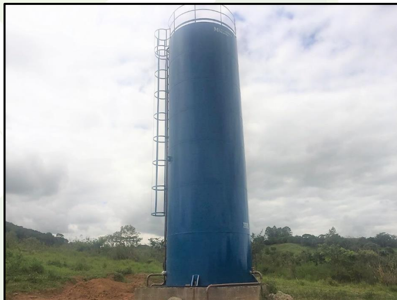
Figura 33 - Vista do Reservatório R09
