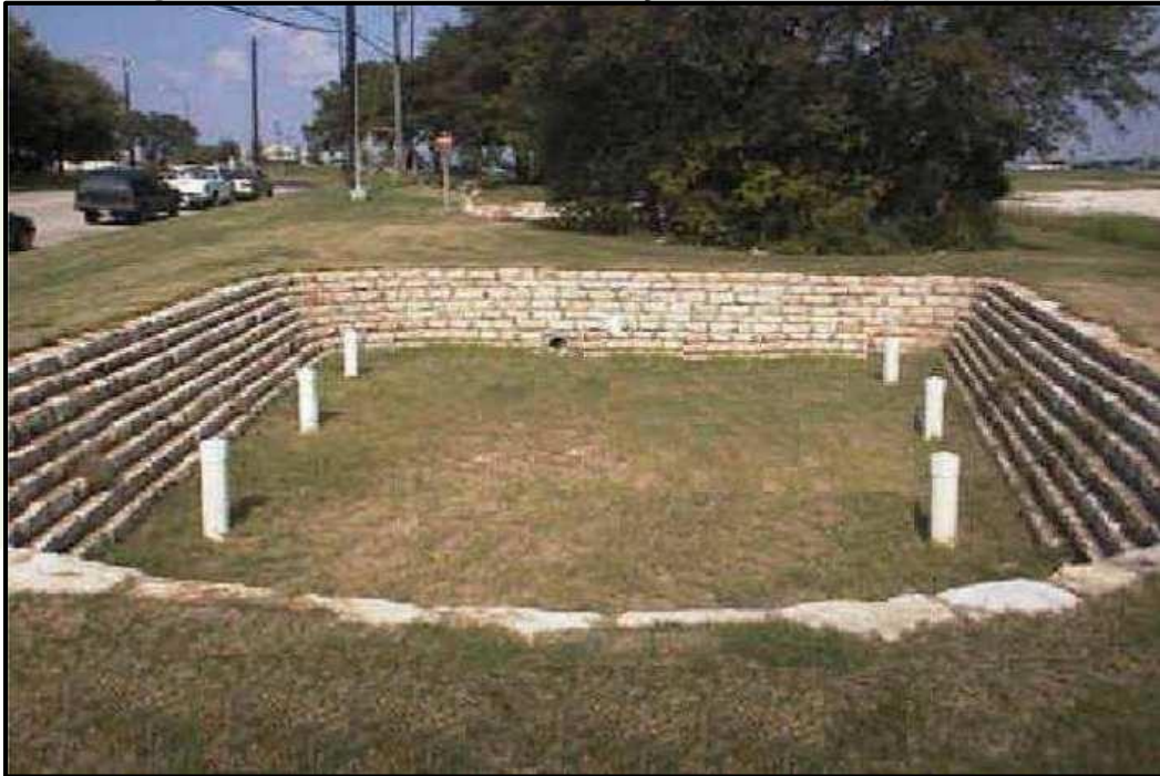
Figura 49 - Reservatório de Detenção de Uma Pequena Área
