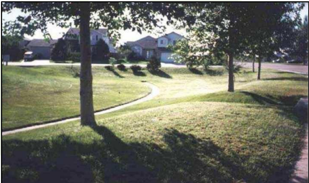
Figura 50 - Reservatório de Detenção Gramado Durante a Seca
