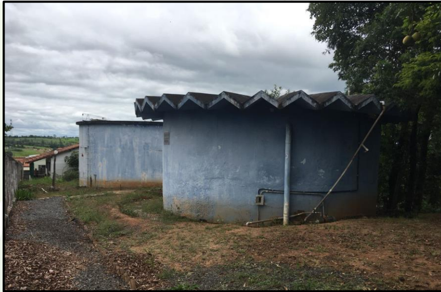
Figura 20 - Vista do Reservatório R01
