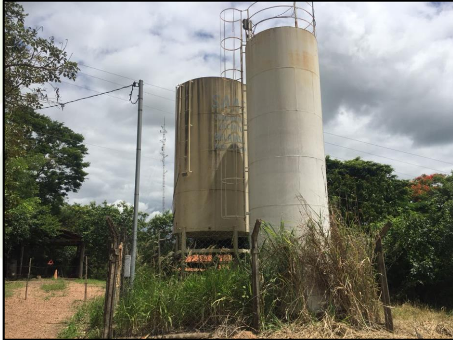
Figura 30 - Vista do Reservatório R07
