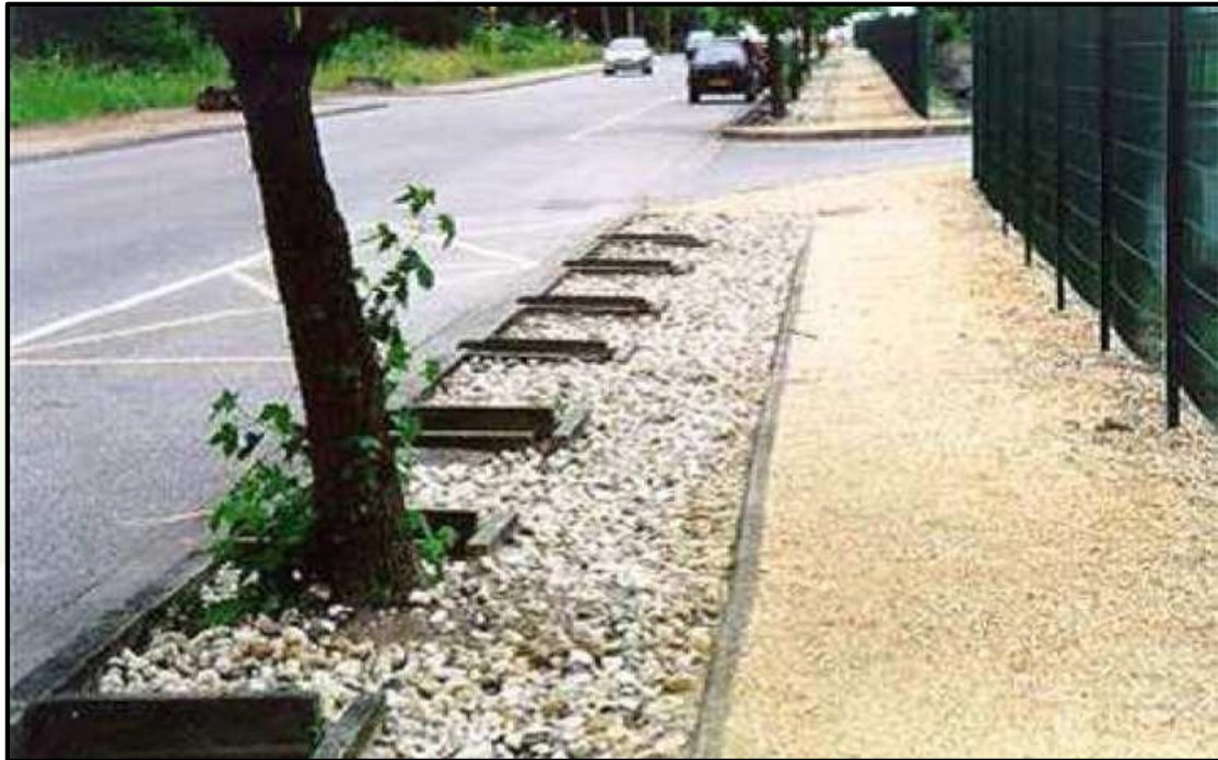
Figura 47 - Trincheira de Infiltração ao Longo da Rua
