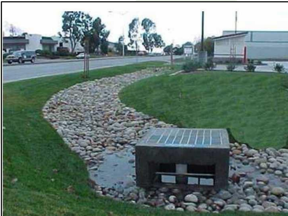
Figura 48 - Trincheira de Infiltração ao Longo da Rua
