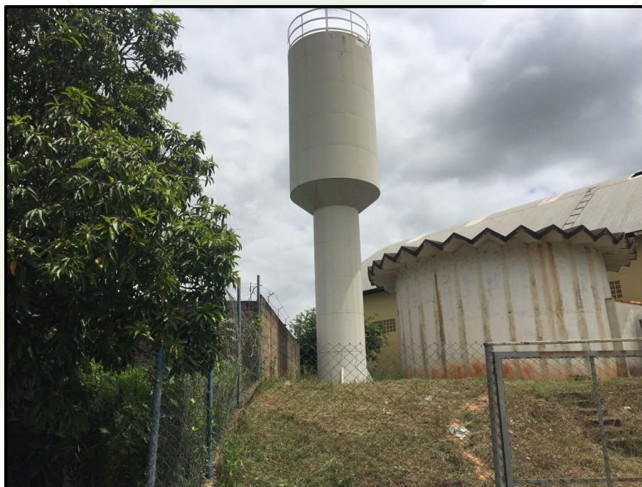
Figura 28 - Vista do Reservatório R06
