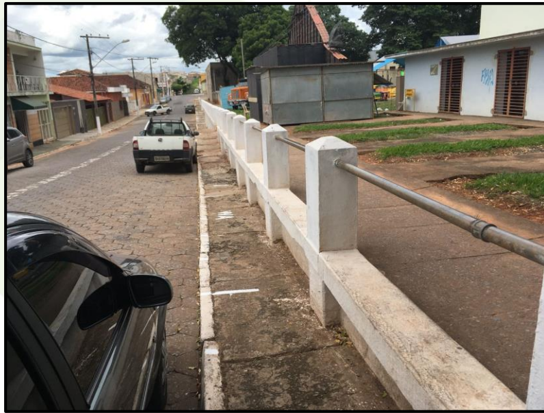
Figura 41 - Local Onde se Encontra a Galeria Subterrânea de Águas Pluviais
