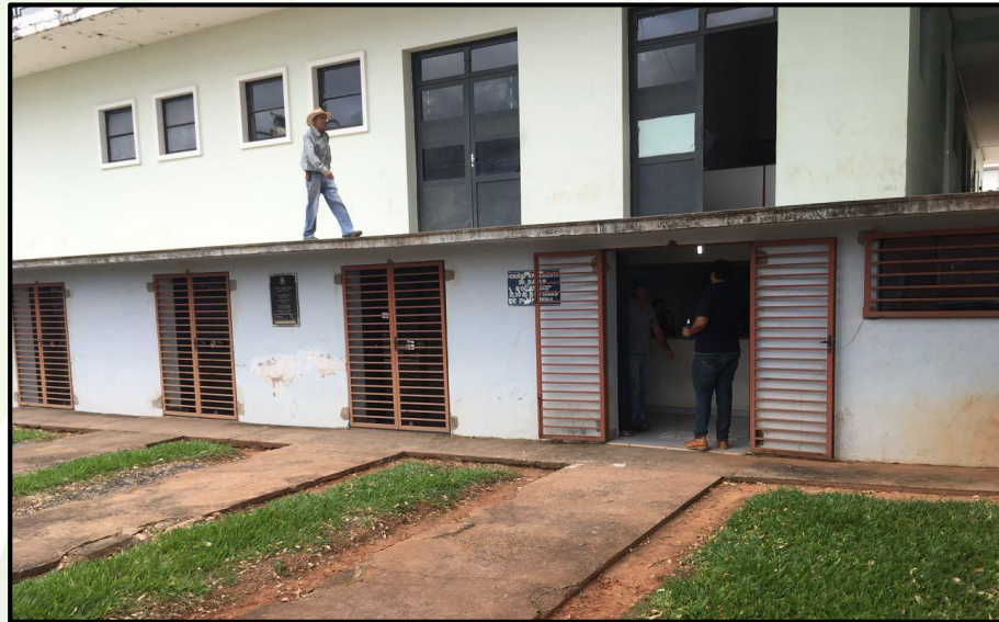
Figura 34 - Vista da Fachada do Serviço Autônomo de Água e Esgoto
