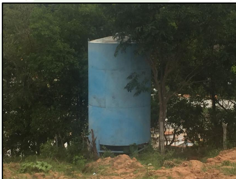
Figura 32 - Vista do Reservatório R08
