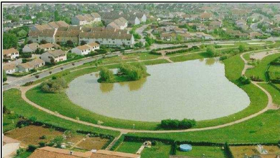
Figura 43 - Bacia de retenção alagada com volume de espera para controle de enchente e áreas de recreação e lazer
