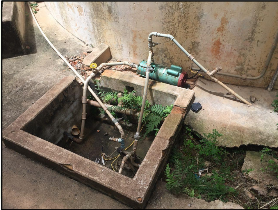
Figura 29 - Vista do Reservatório R06
