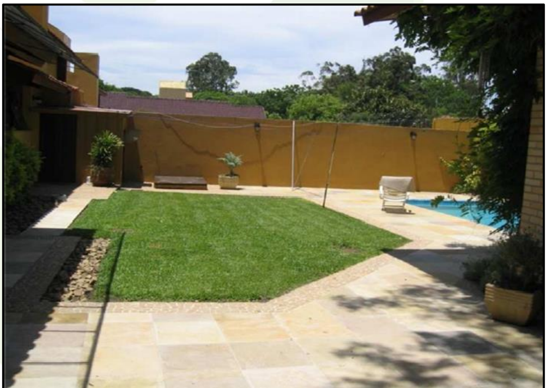
Figura 52 - Trincheira de Infiltração em Lote Residencial
