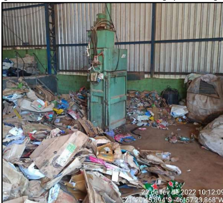
Figura 54: Prensa hidráulica de resíduos no galpão de triagem.
